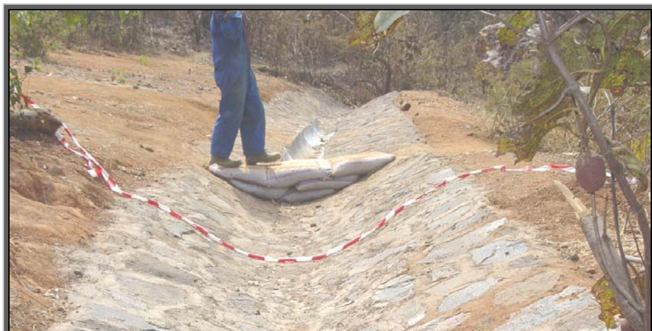
Emprise du Pipeline après correction de l'érosion
