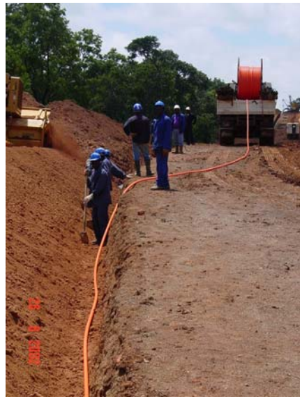
Pose du câble à fibres optiques pendant la phase de construction du pipeline
