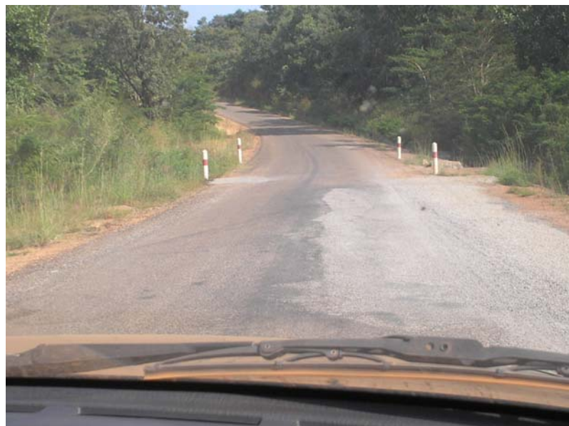
Un tronçon réfectionné de la route Ngaoundal- Meidouougou
