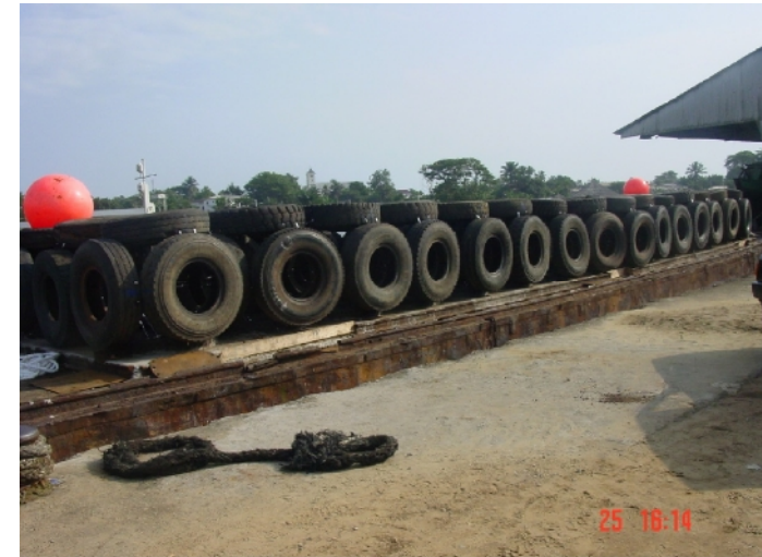
Vue du récif artificiel au port de Kribi avant son coulage. Sur chaque extrémité, en rouge, des ballons servant de balise.
