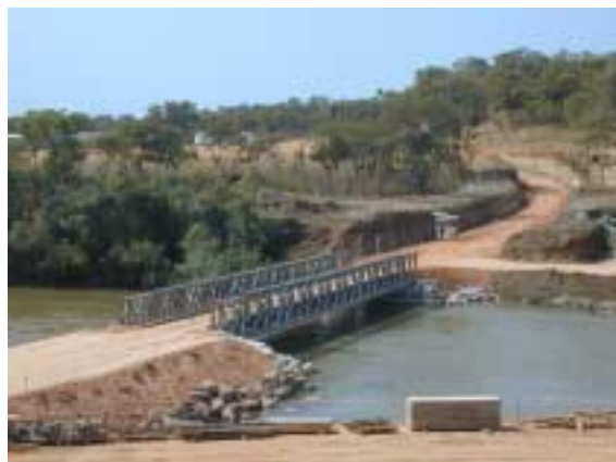
→ Une vue du pont provisoire sur la Mbéré.
