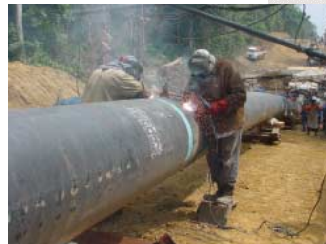
Soudure manuelle des tuyaux avant leur enfouissement
