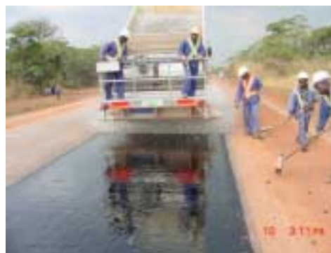
Travaux de réparation de la couche de roulement
