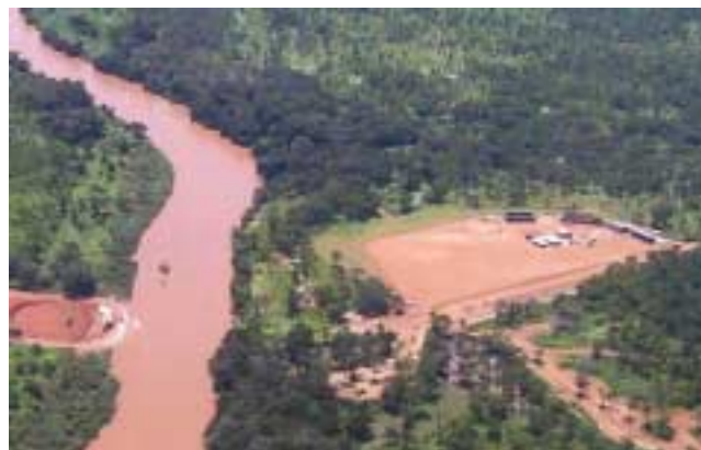
→ Vue aérienne de la rivière Mbéré. A droite, la rive camerounaise et l'aire de stationnement des camions aménagée par le Projet.
