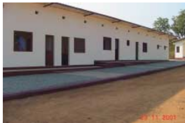
Une vue des bâtiments du Poste frontalier près de la rivière Mbéré, construits et équipés par COTCO. Ils abriteront les services de Police, de Douanes et de Gendarmerie.
