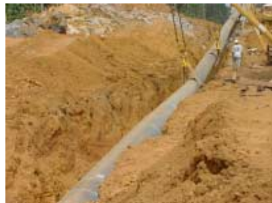
3 Pose du pipeline dans la tranchée
