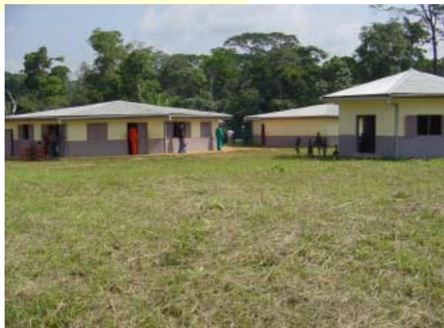
La construction de cet internat pour écoliers, dans une localité située non loin de Lolodorf, a bénéficié du soutien de COTCO.
