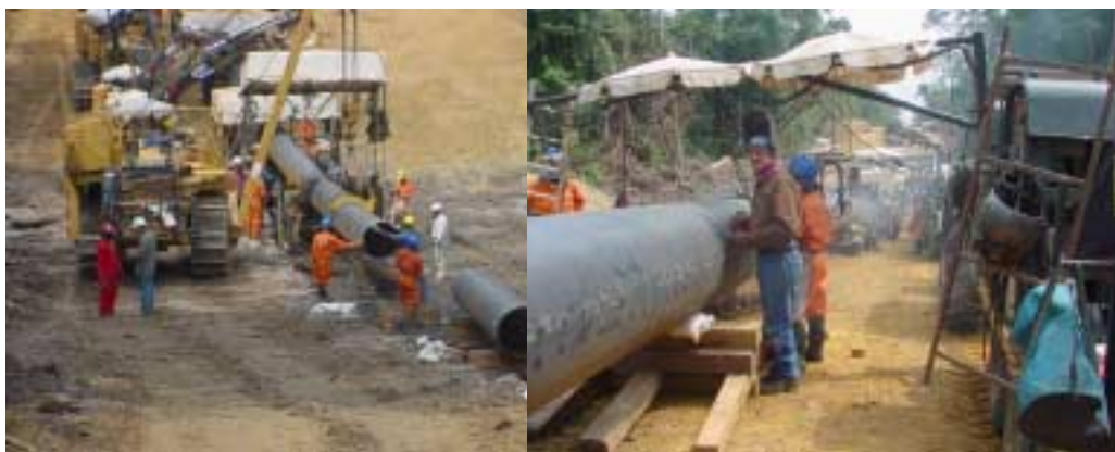
2 Soudure du pipeline
