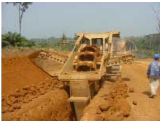
1 Creusement de la tranchée
