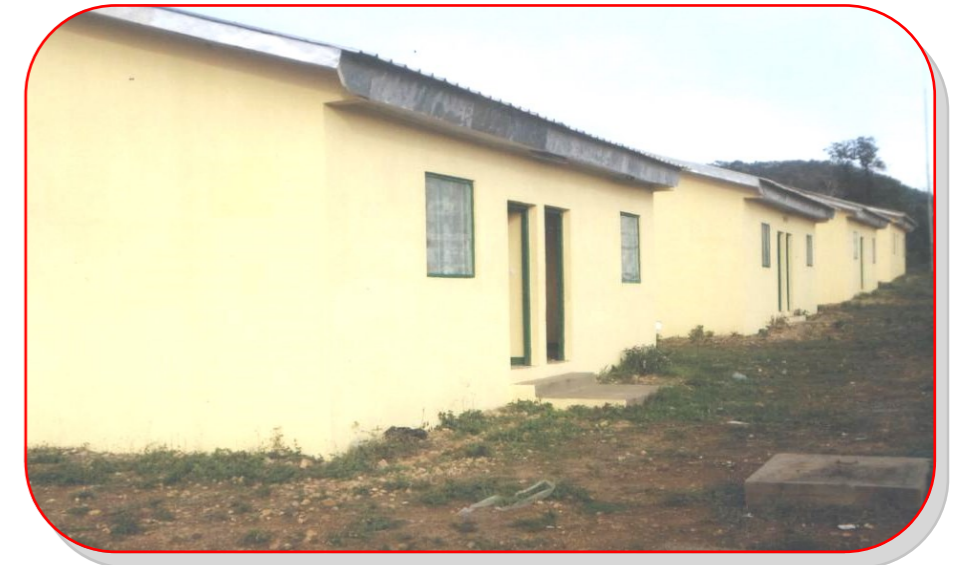
Une vue de certains bâtiments réhabilités à la Brigade de Gendarmerie de Dompla
