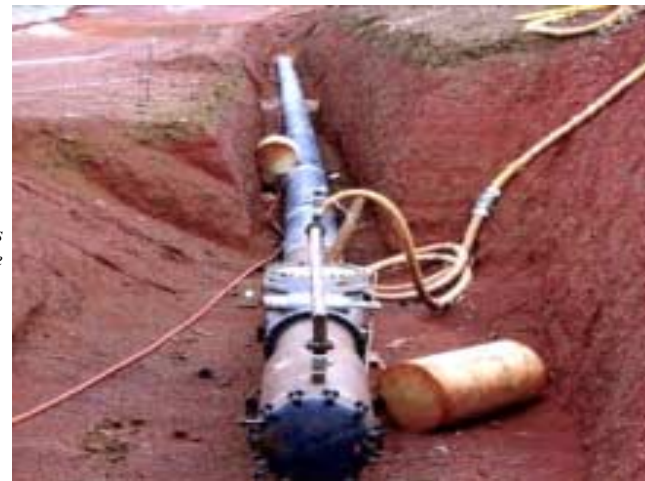
Epreuves hydrauliques sur une section de pipeline
