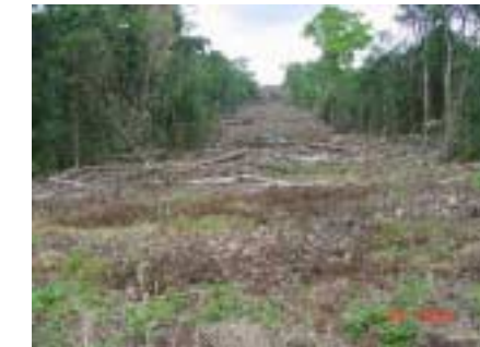
Couloir du pipeline
