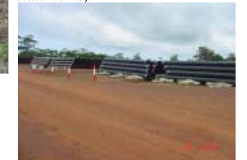
Site d'une aire de stockage
