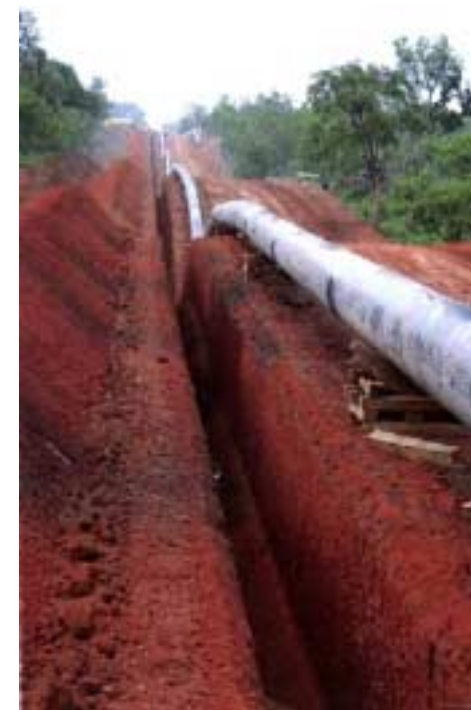
Pipeline à côté de la tranchée dans la partie nord du tracé, prêt à être enfoui.
