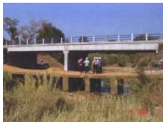
Vue d'un pont construit par Sogea/Satom, sur l'axe Ngaoundal-Pont sur la Mbéré. Au 1 er plan, l'ancien pont
