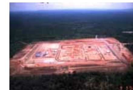
Le site de la station de pompage de Bélébo
