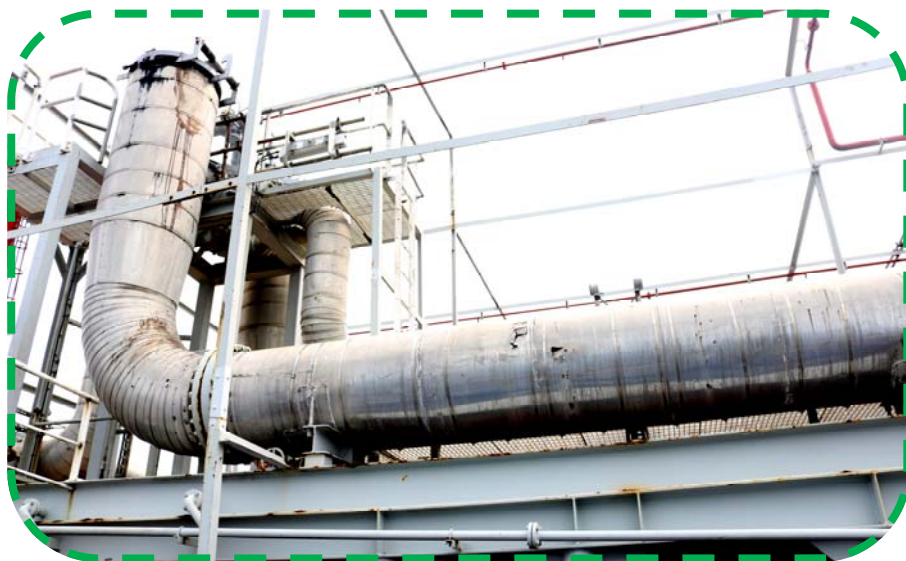
Une vue de la boucle d'étalonnage du Terminal Komé-Kribi 1 (KK1)
