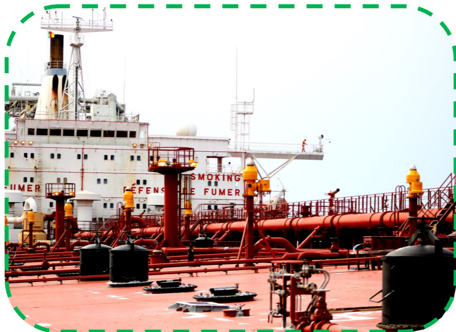
Le Terminal Komé-Kribi 1 a également été inspecté pendant la dernière campagne des inspections des installations classées du Pipeline Tchad/Cameroun et de son système de protection cathodique
