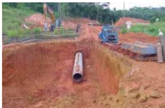
Enfouissement d'un pipeline enrobé de béton
