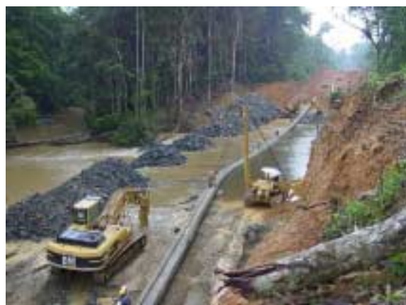
← Travaux sur le lit du fleuve Lokoundje, dans la région de Kribi
