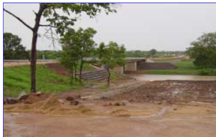
Le pont frontalier sur la rivière Mbéré, construit par le Projet: un puissant vecteur de l'intégration sous-régionale
