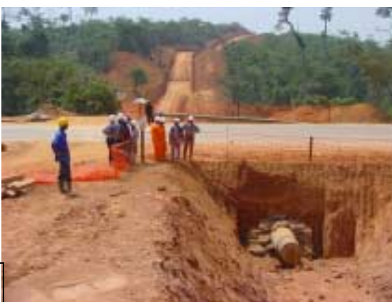
Une traversée de route bitumée
