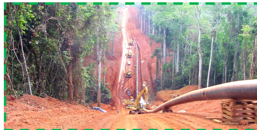
Un tronçon du Pipeline Tchad/Cameroun lors de la phase de construction
