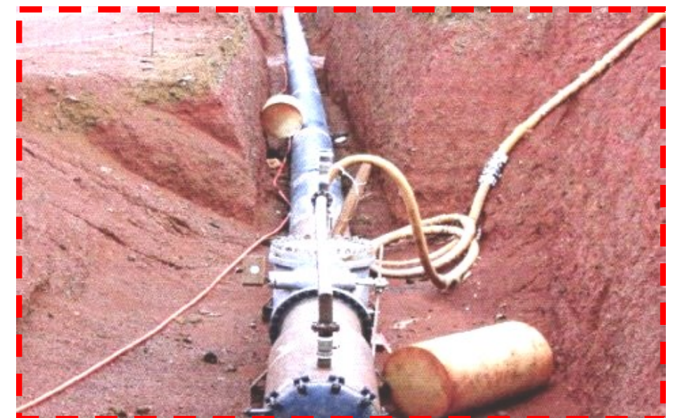
La face interne du Pipeline a été nettoyée
