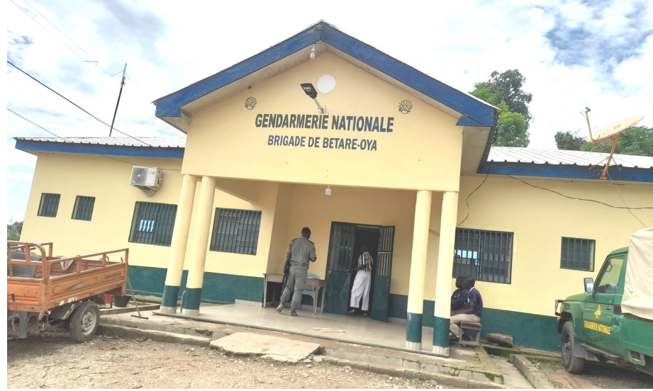
Les systèmes de transmission de la brigade de gendarmerie de Betare-Oya ont été inspectés
