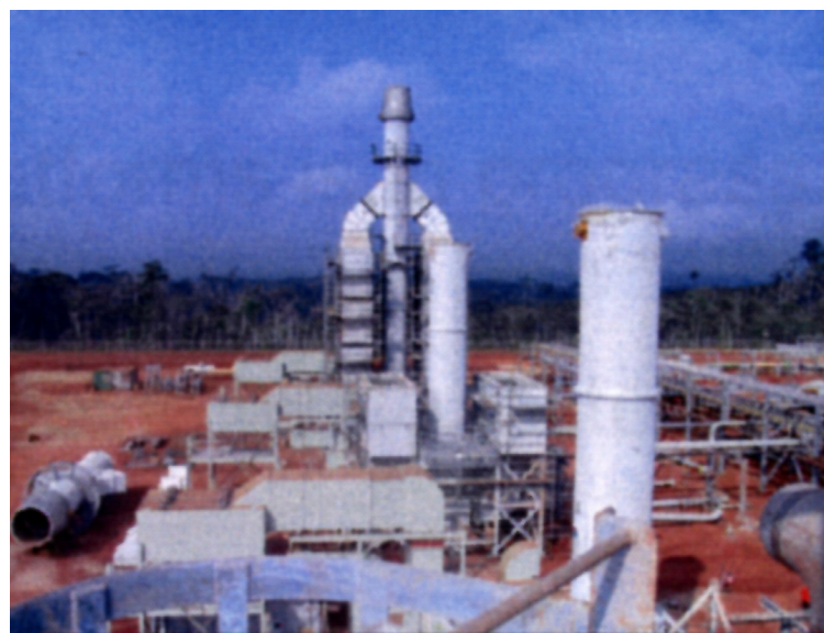
Montage des pompes et turbines dans une station de pompage
