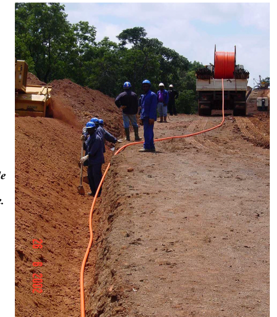
Pose de la gaine du câble à fibres optiques dans la tranchée
