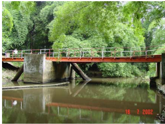
Pont sur la Mougoué, près de Bipindi
