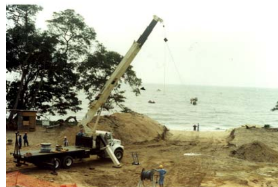
Creusement de la tranchée du pipeline sous-marin
