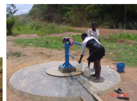
Puits construit à Ngoumou
