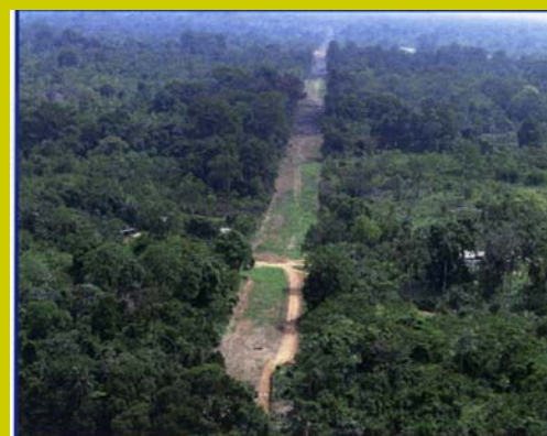
Le tracé du pipeline fait l'objet d'un survol aérien régulier, pour les besoins de surveillance de l'ouvrage
